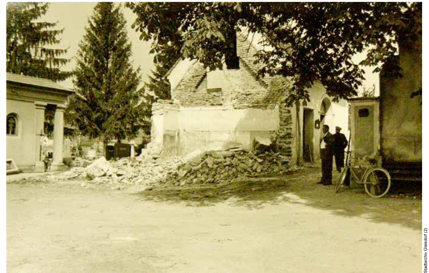
Gebäudeabriss beim Bau der Aufbahrungshalle in Gleisdorf, Ende der 60er Jahre
